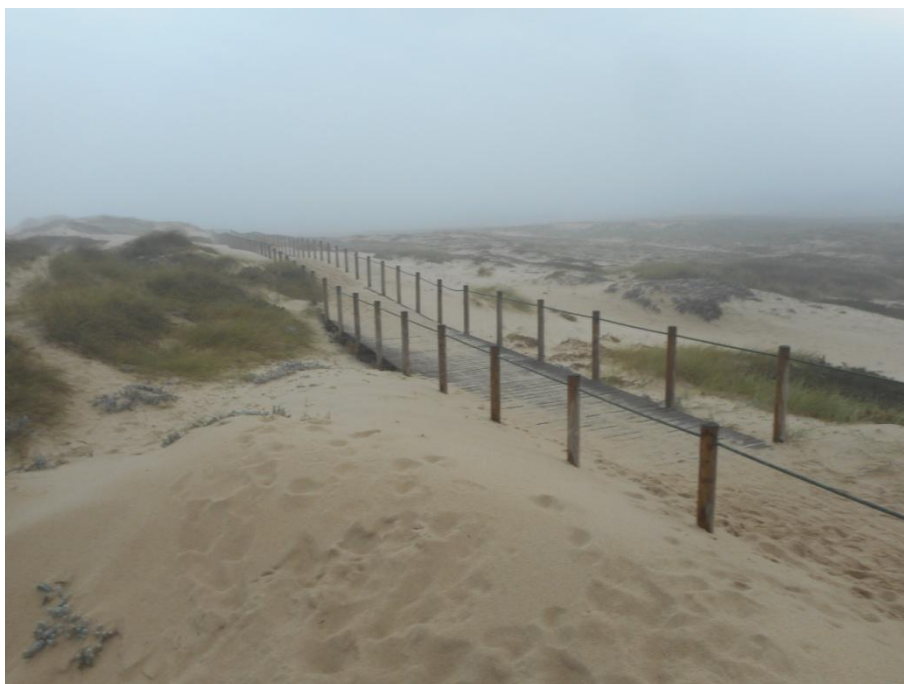
PASSERELLE VERSO LOUÇA MINDELO
